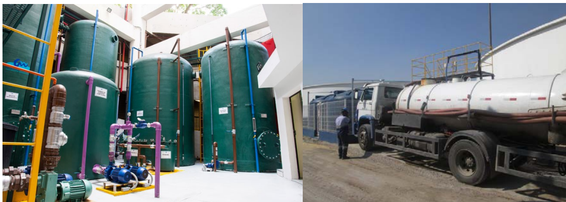
Figura 5: Sistema de tratamento de água de Reuso em shopping em SP. Figura 6 :Carregamento de carro pipa com água de Reuso do sistema piloto da ETE Deodoro (FOZ AGUAS 5)
